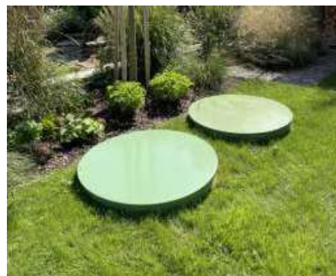
ČOV TOPAS DUO REUSE po instalaci
